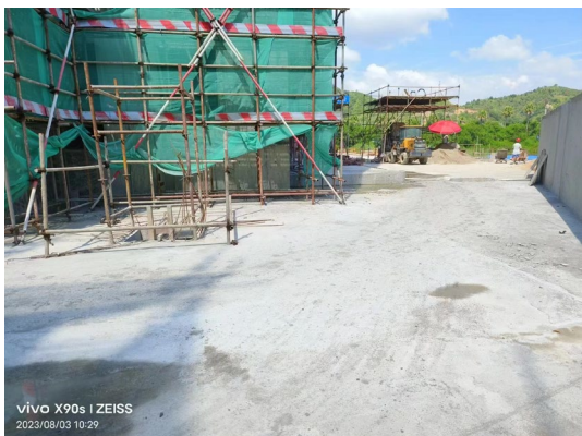
一期工程已硬化场地
