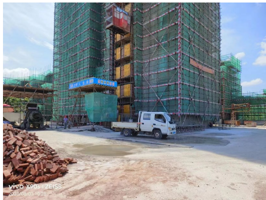
7#楼基础以上主体施工
