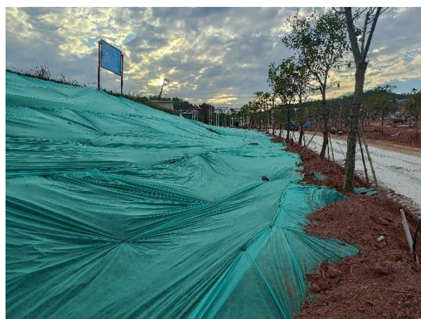
照片4 边坡绿化现状
