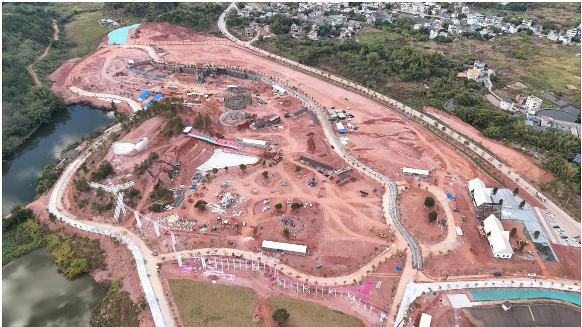
照片2 项目区施工现状
