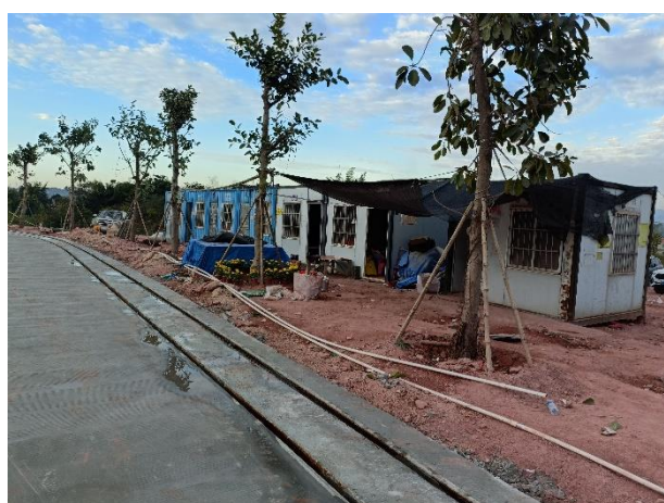
照片7 施工临建区现状
