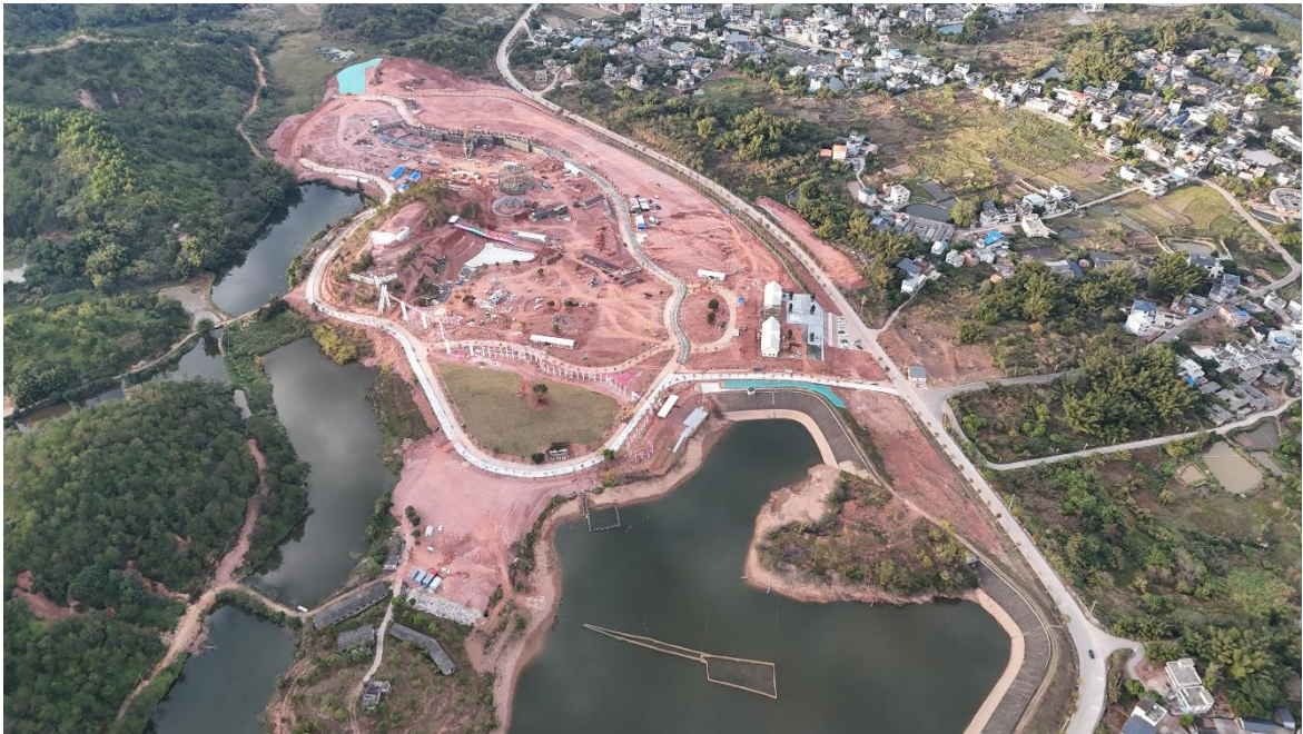
照片1 项目区全貌
