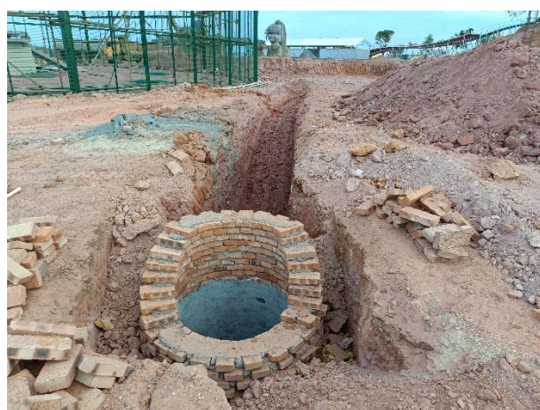
照片8 沉砂池现状
