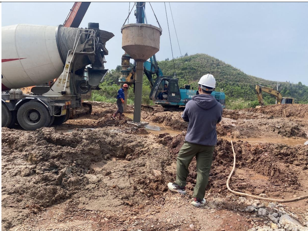
光伏场地施工现状图
