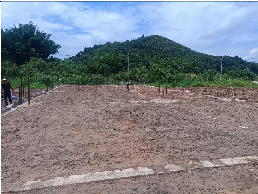
房建施工现状图
