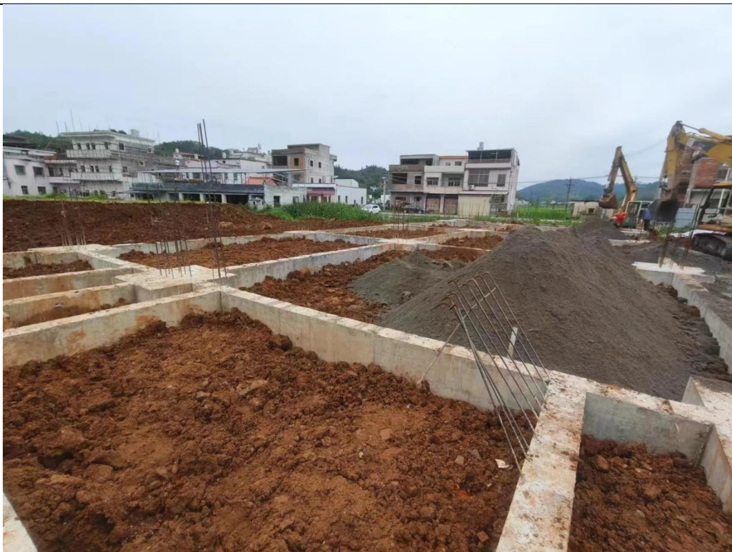
房建施工现状图
