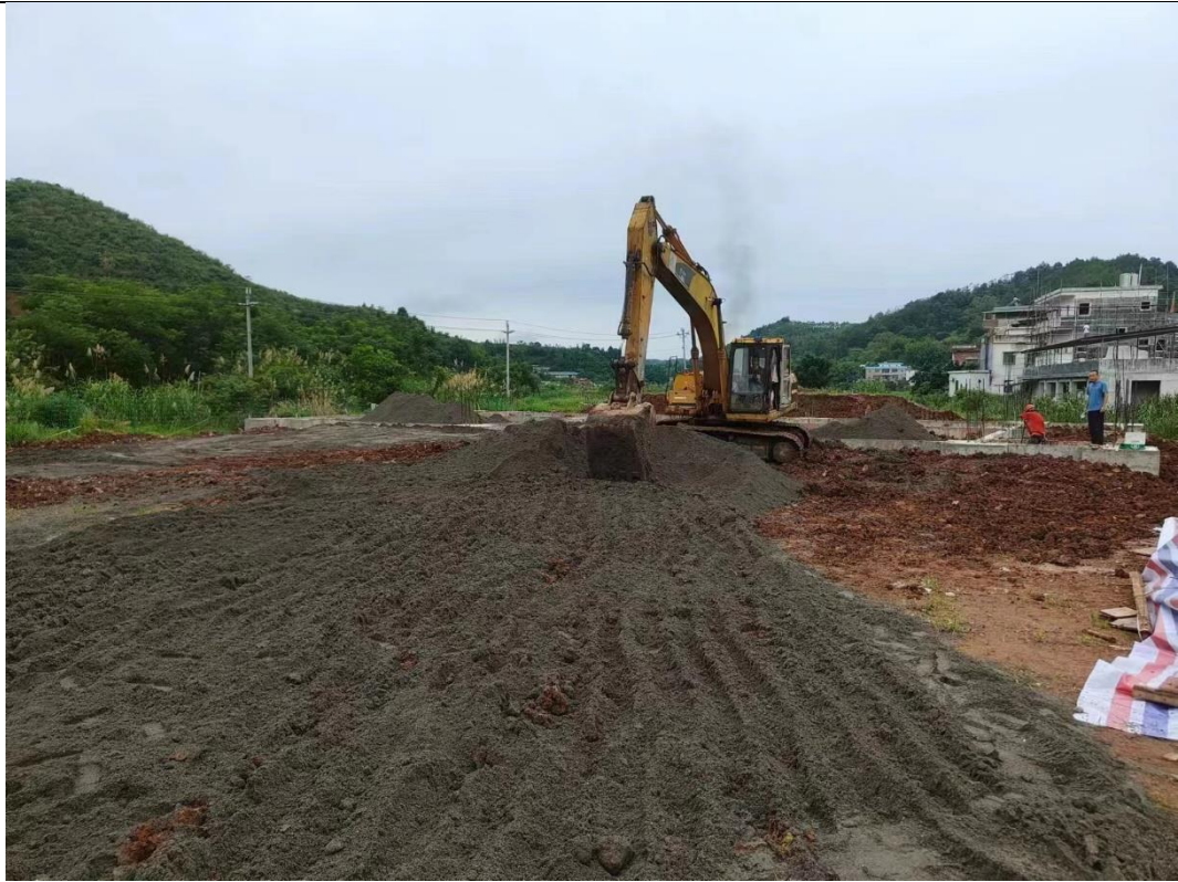
道路工程施工现状图
