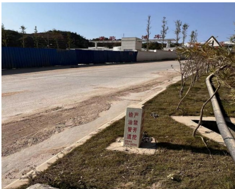
图13.2-1 管线沿线警示标识（1）
