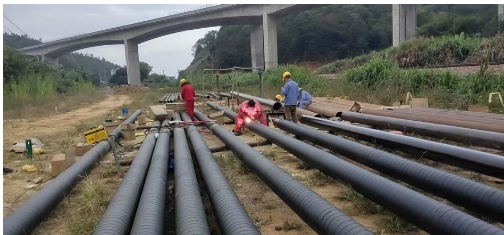
图5.1-1 管道施工作业情况示意图（1）
