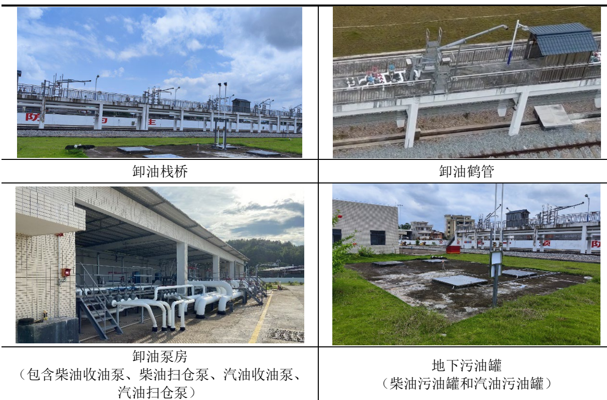
图2.3-2 项目主要设备实际建设情况示意图
