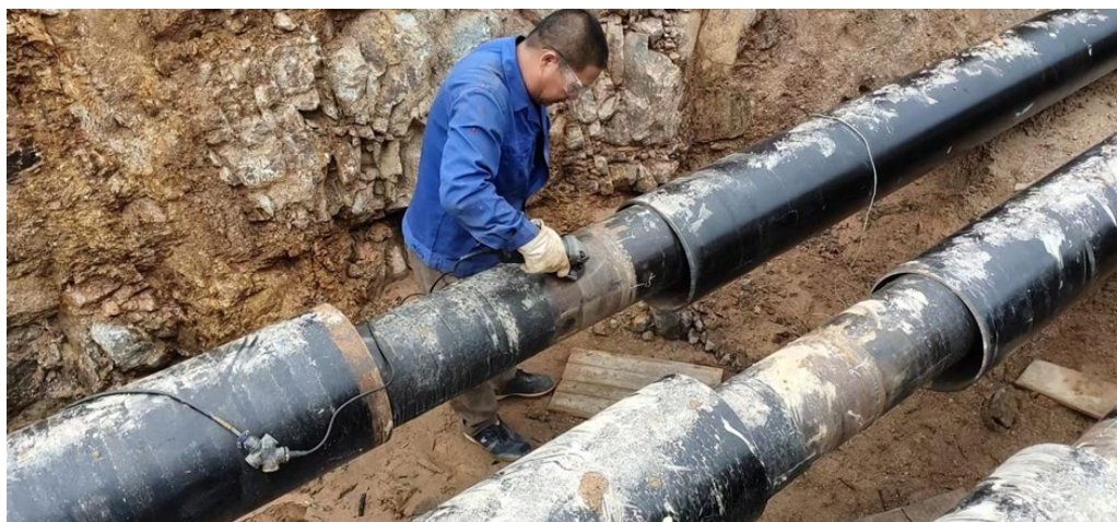
图5.1-2 管道施工作业情况示意图（2）
