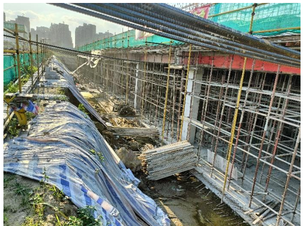
照片4 地下室顶板施工
