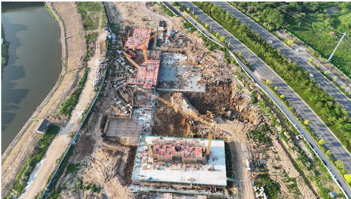
照片2 项目区施工现状
