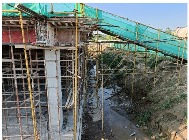
照片8 基坑周边排水沟
