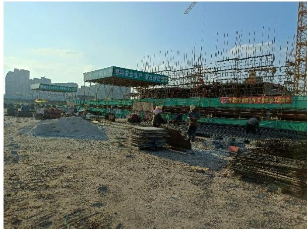
照片5 钢筋加工场
