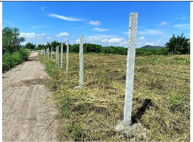
照片 2 施工临时道路
