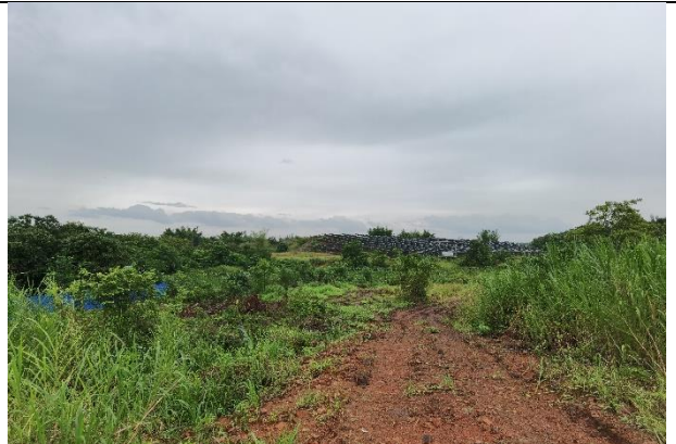
照片 6 施工临时道路
