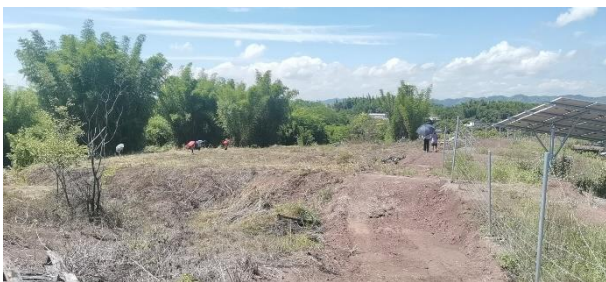
照片 5 布置光伏板区域
