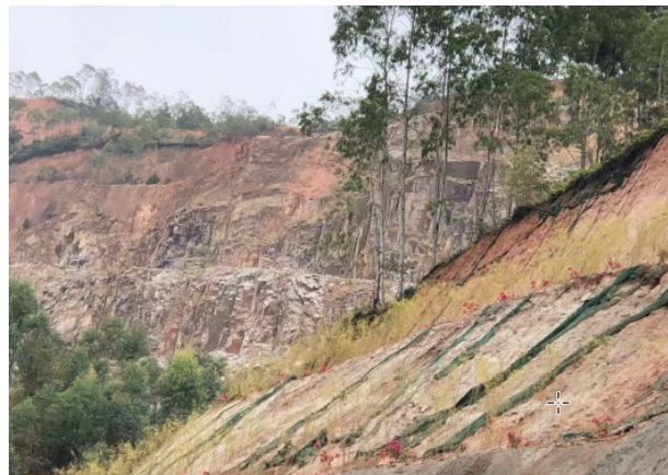
工业场地区边坡绿化
