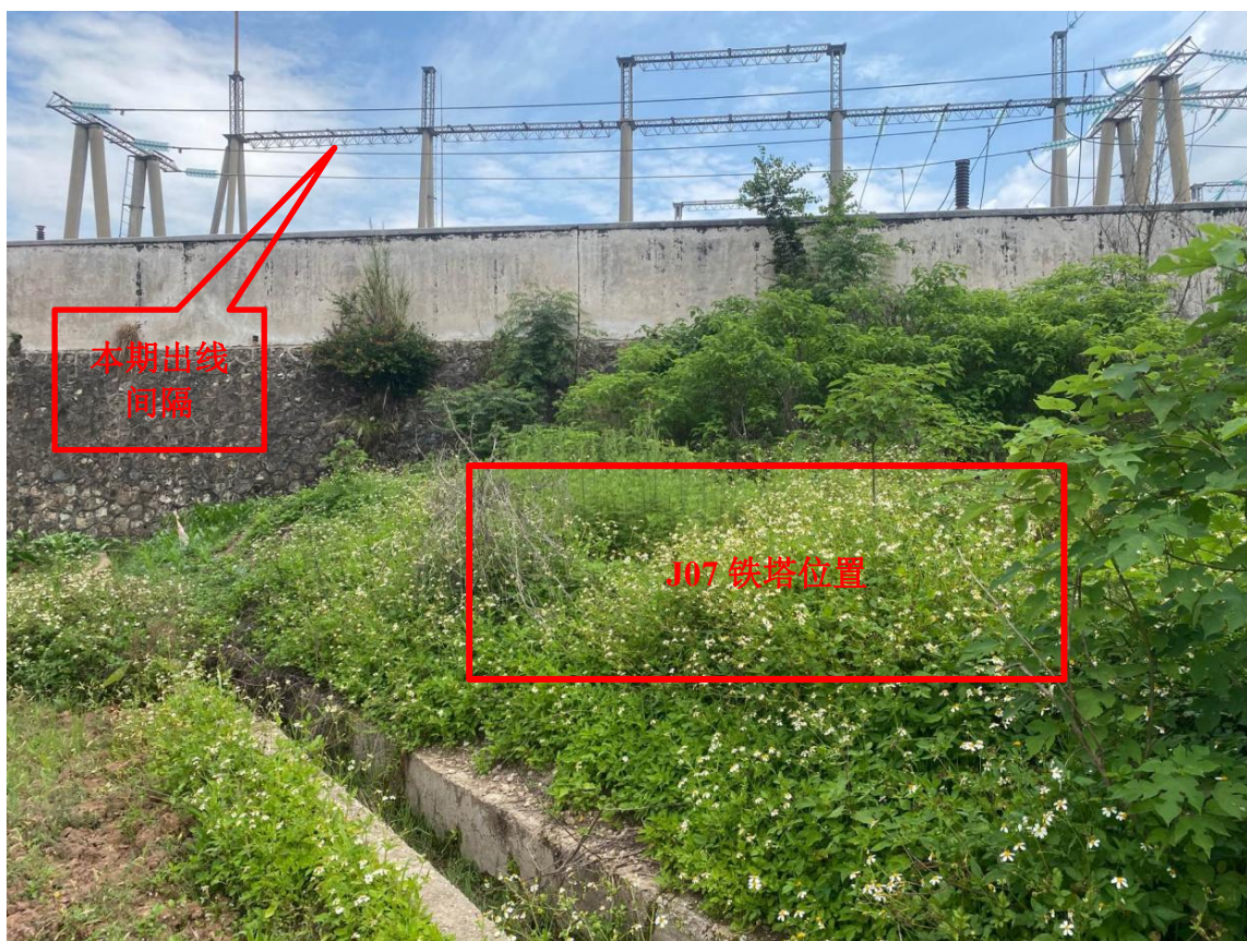
220kV 兴宁站 110kV 侧出线现场照片
