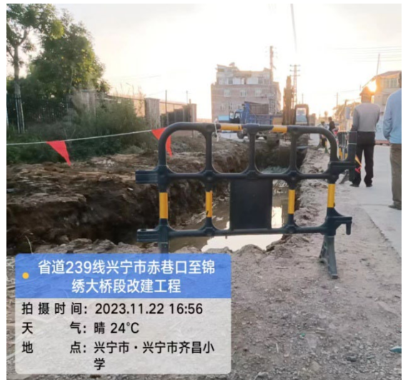
已破拆路面（K134+800）
