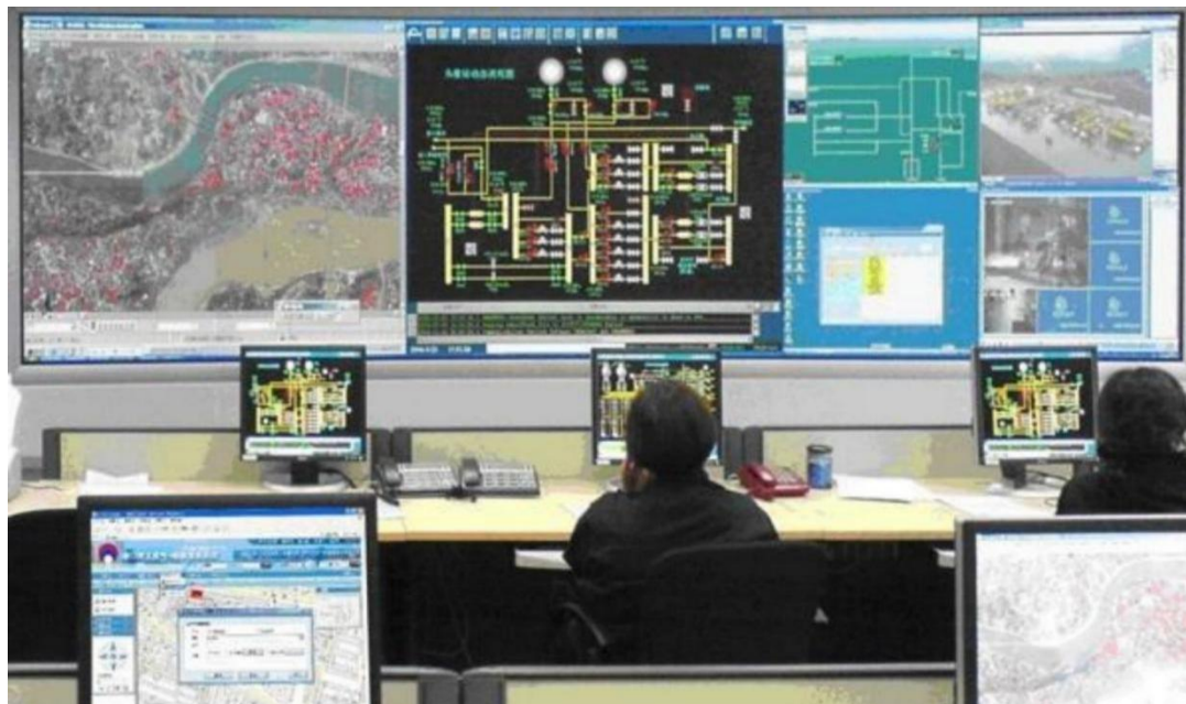
图8.2.1-2 调度中心SCADA系统示意图
