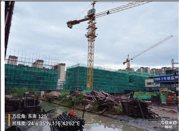
项目区施工现状图
