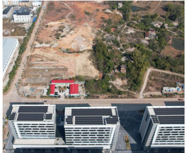
项目北面——其他企业园区道路
