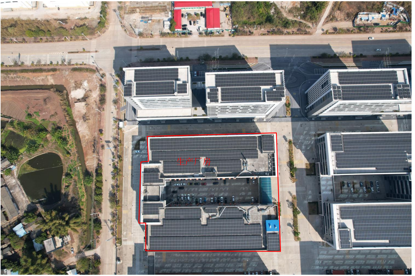
生产厂房现状实景航拍图
