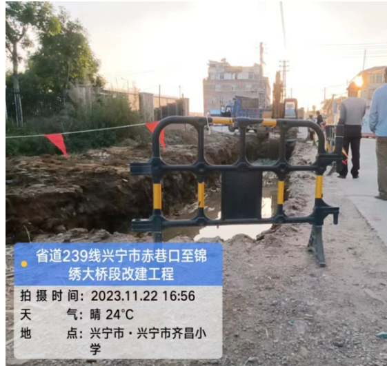
已破拆路面（K134+800）
