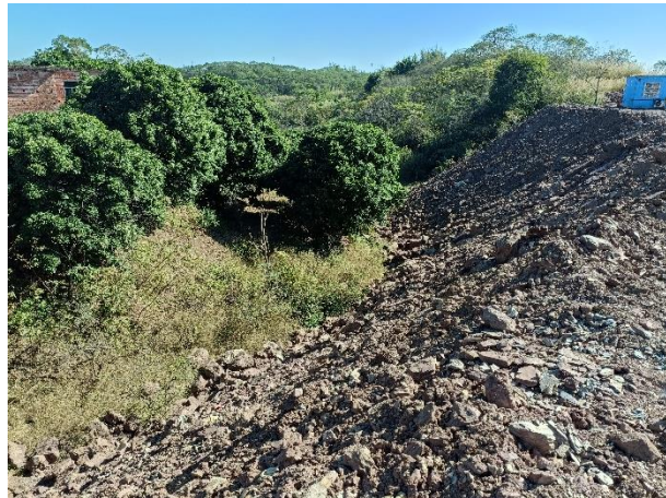
照片5 项目区边坡现状
