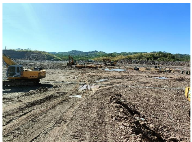
照片8 项目区施工现状
