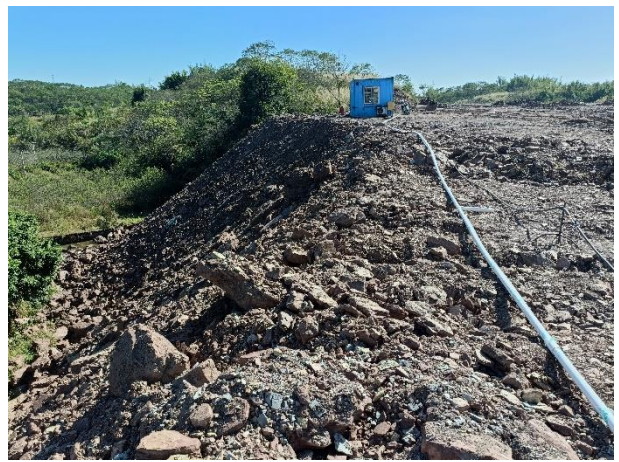
照片4 项目区边坡现状
