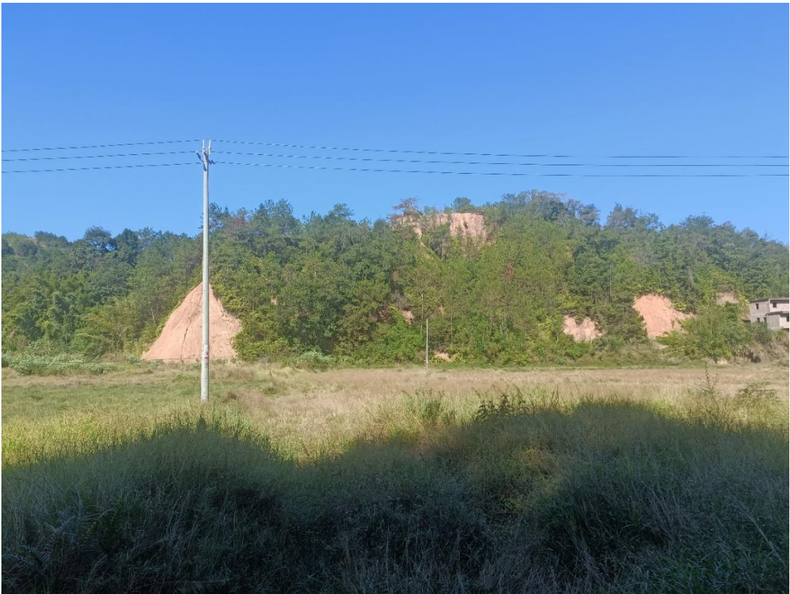
图5 二号支洞出口现状
