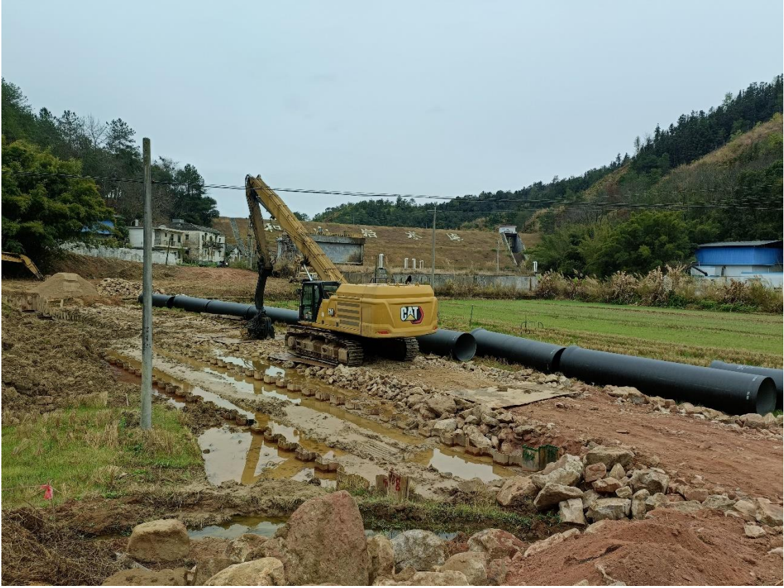
图8 净水厂施工现状
