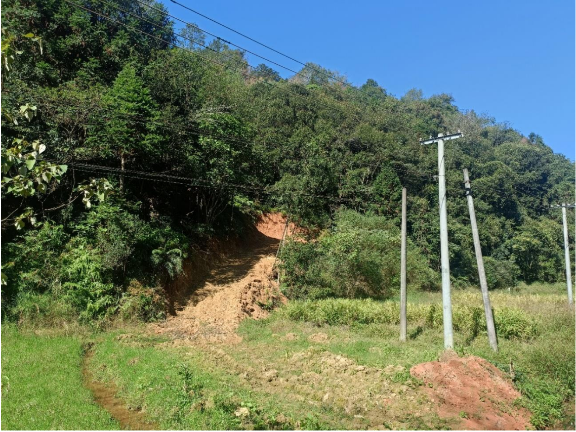
图4 一号支洞出口现状
