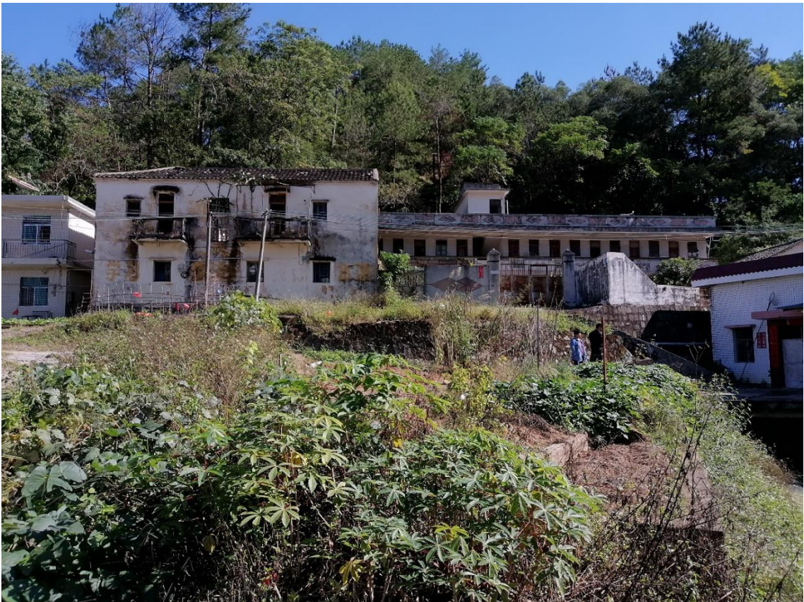
图7 拟建净水厂位置现状（原和山岩水库管理所旧址）
