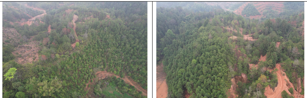
新建 110kV 礼教站站址现状
